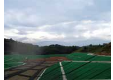
笛吹市の最終処分場を視察
